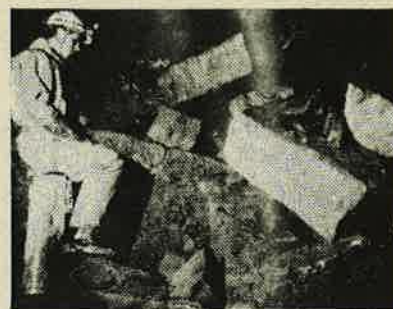
Un spéléologue constate la chute de blocs, récemment tombés comme en témoignent les éclats sur les rochers.
